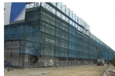
新城工場 (建設中)
